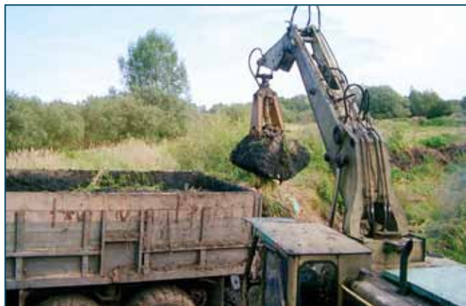
Fot. 1. Ładowarka – załadunek osadów na środki transportowe
