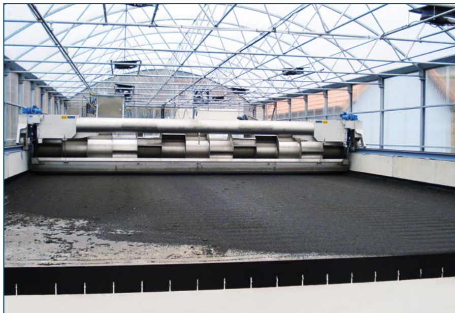
Fot. 2. Suszarnia we Francji wyposażona w ogrzewaną posadzkę z systemem odzysku ciepła ze ścieków
