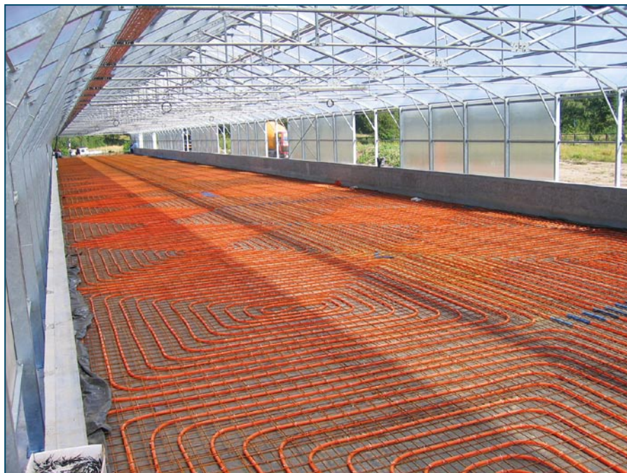
Fot. 4. Posadzka suszarni słonecznej wyposażona w system grzewczy
