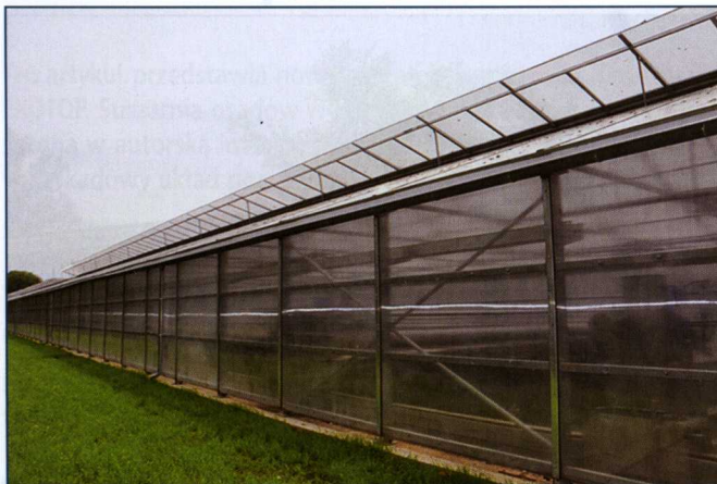
Fot. 9. Uchylne okna dachowe w kalenicy hali, dołem szczelina wentylacyjna
