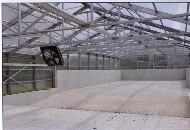
Fot. 5. Część magazynowa wysuszonego osadu
