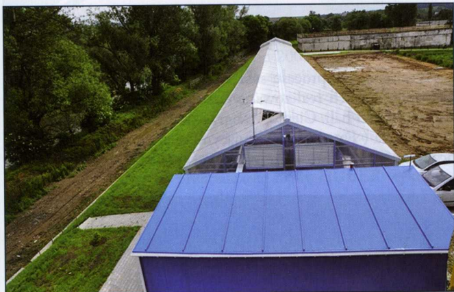
Fot. 3. Widoczny na pierwszym planie kontener stacji mechanicznego odwadniania osadów
