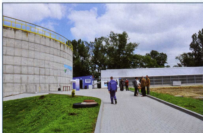
Fot. 2. Stacja odwadniania osadów i suszarnia zlokalizowane są w bezpośrednim sąsiedztwie WKF
