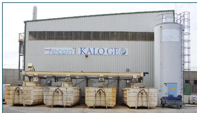
Fot. 1. Budynek spalarni
